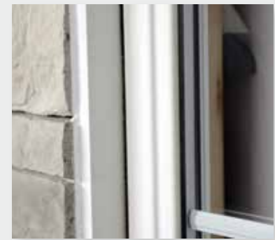
Finition avec moulure d'aluminium
